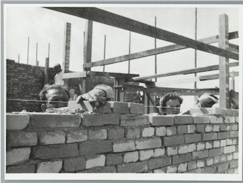
Bouwvakkers aan het werk in 1946
